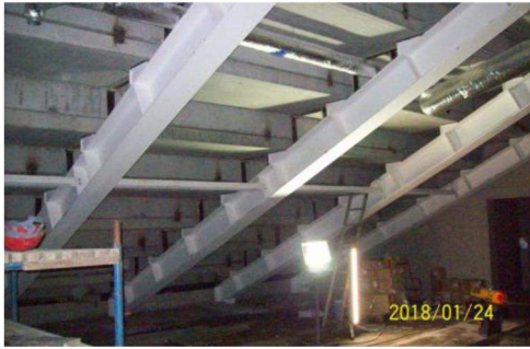
Konstrukcje stalowe trybun
