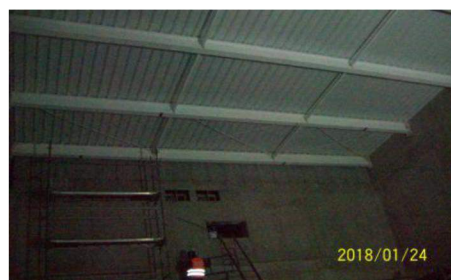
Pokrycie dachu płytami izolacyjnymi
