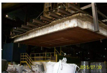
Transport zdemontowanego stropu pieca
