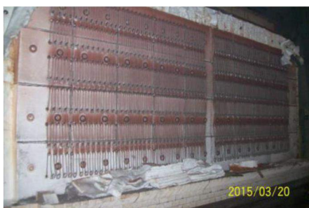
Demontaż ściany komory roboczej
